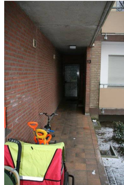
Fotos: Wohnbau Münsterland mit Architekturbüro Farwick + Grote
