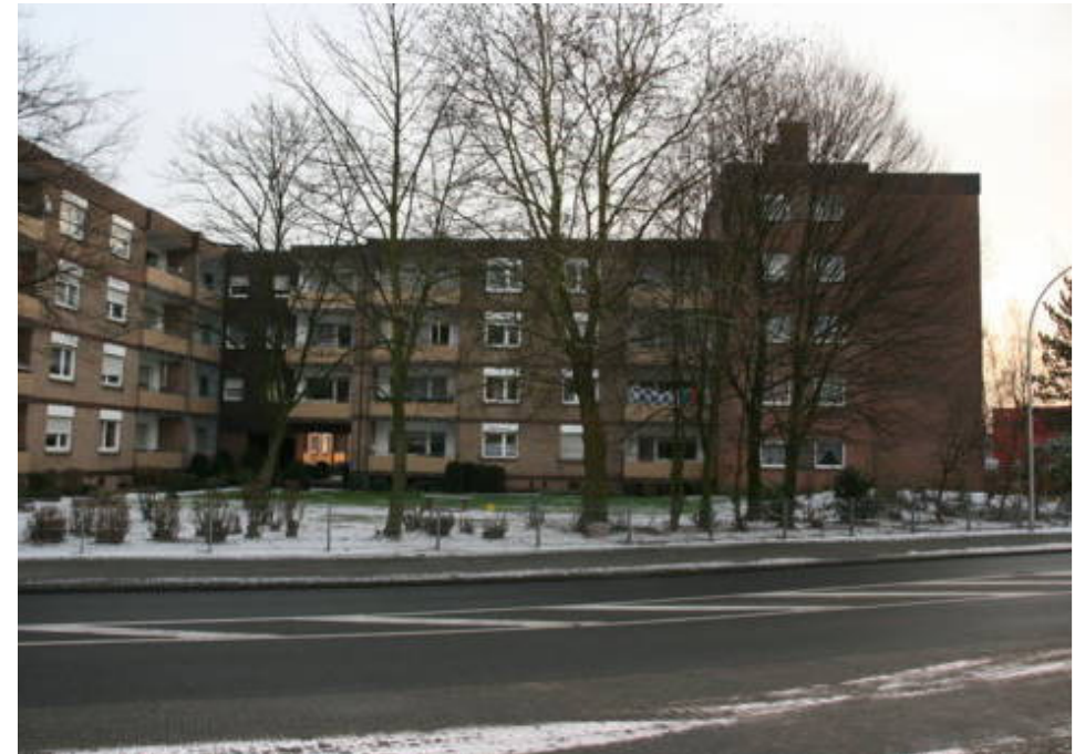
Fotos: Wohnbau Münsterland mit Architekturbüro Farwick + Grote
